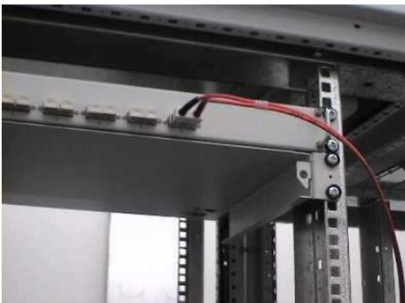
Gehäuse wird unabhängig von der Schublade an der 19"-Ebene befestigt.
