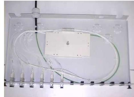
Fertig gespleißte Schublade. Ankommendes Kabel (links oben) ist mittels Verschraubung und Kabelbinder fest mit der Schublade verbunden.
