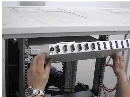
Fertig gespleißte Schublade wird in das vorher montierte Gehäuse eingehängt.
